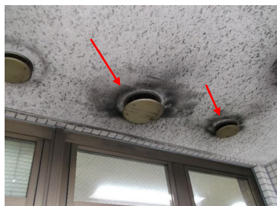
<ふじみ野分署、吹出口汚れ>
