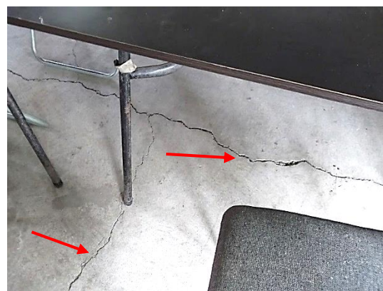
<三芳町消防団第5分団、床のひび割れ>
