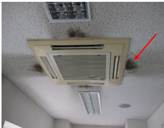
<三芳分署、エアコン吹出口>
