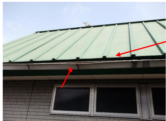
<ふじみ野消防団第5分団、屋根樋>
