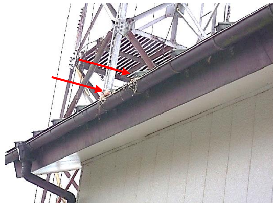
<ふじみ野消防団第10分団、屋根樋>
