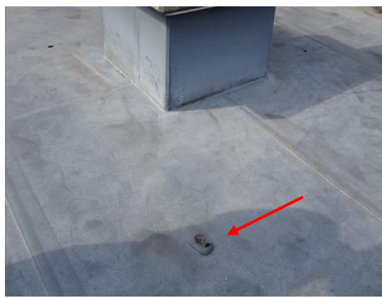
<東消防署、屋上防水穴>
