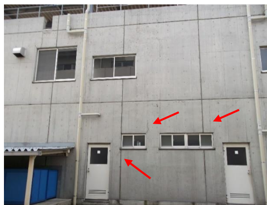
<東消防署 B 棟、外壁ひび割れ>
