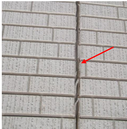
<ふじみ野消防団第5分団、外壁ひび割れ>
