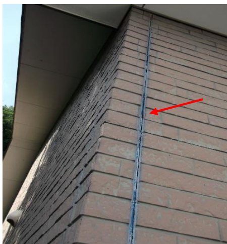
<ふじみ野消防団第8分団、外壁のひび割れ>
