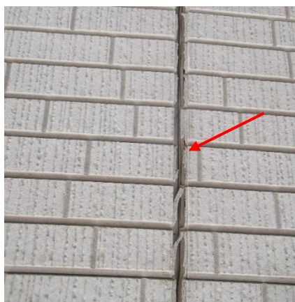
<ふじみ野消防団第5分団、外壁ひび割れ>
