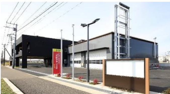
北東側からの「車庫棟・庁舎棟」
