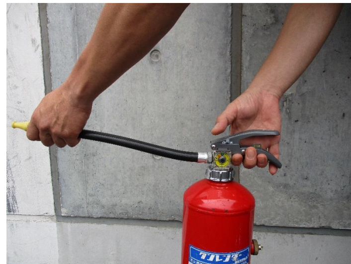
②ホース先端を持ってホースを外し、ホースを前方に向ける。
